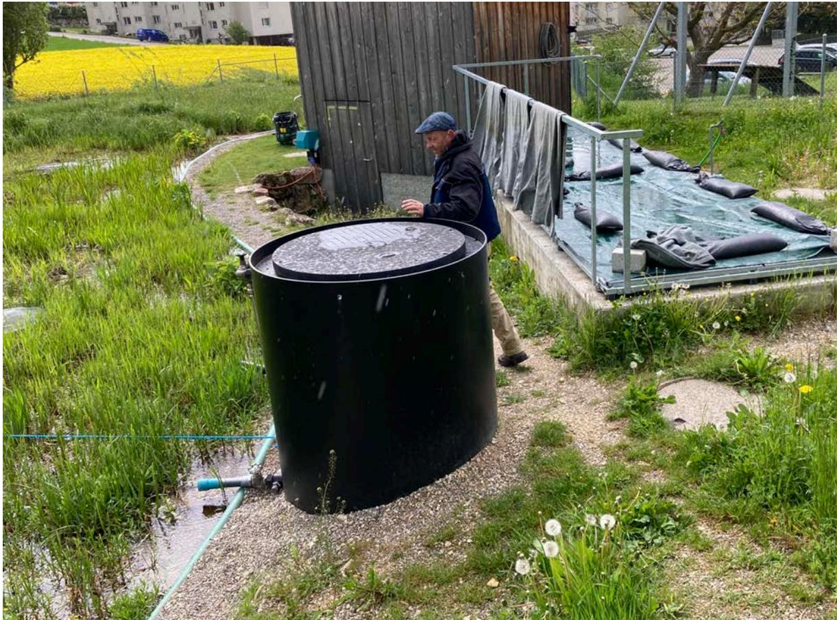
Abbildung 16: Eisenoxydfilter zur Phosphorelimination im Frischwasser
