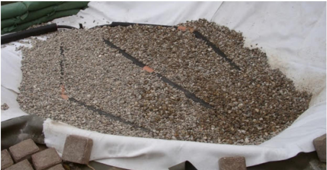
Abbildung 36: Nicht nachhaltig aufgebauter Pflanzen-Kiesfilterunterbau, ohne Rückspül- und Bodenreinigungsmöglichkeit.
