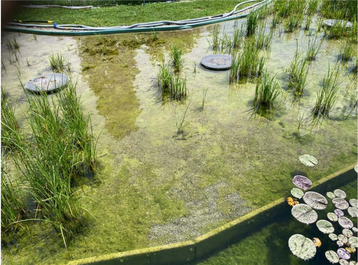
*Abbildung 6: Spärlich bewachsener Pflanzensandfilter auf der Ansaugseite der Pflanzensandfilter-Zone.*
