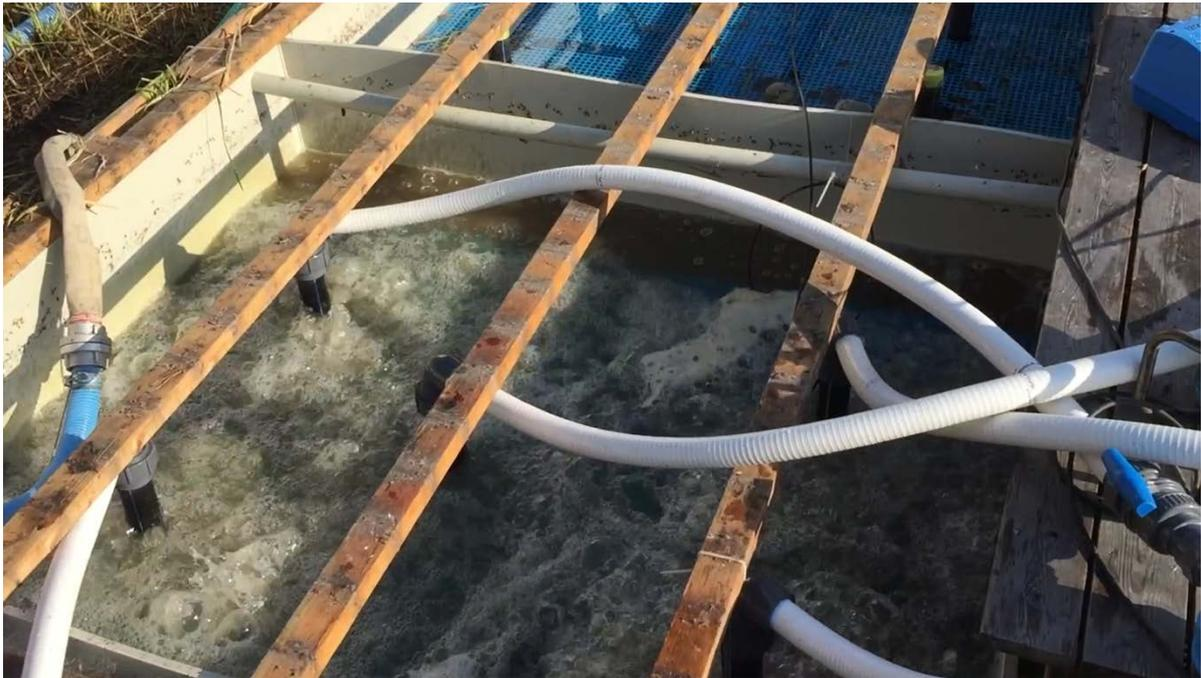
Abbildung 39: Rückspülung eines Schwebebettfilters mit Lufteinwirkung (Blower)
