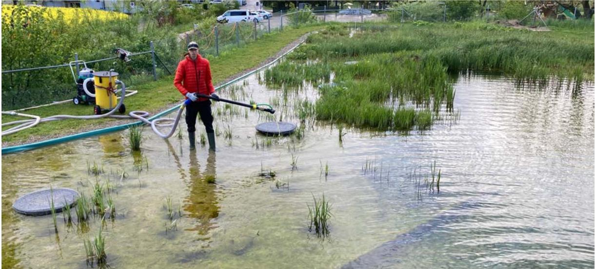
*Abbildung 18: Manuelles Absaugen der Oberflächen des Pflanzensandfilters, 08.07.2021*
