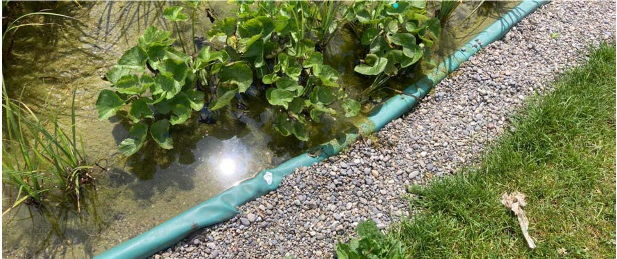
Abbildung 17: Abgesenkter Teil des Stellriemens beim Rand des Pflanzenfilters (Bachseitig) dient als Überlauf des Systems.
