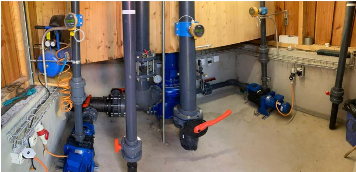
Abbildung 3: Technikraum mit Pumpen für Kleinkinderbad, Hauptbad und Skimmer im Regenerationsbereich, 08.07.2021
