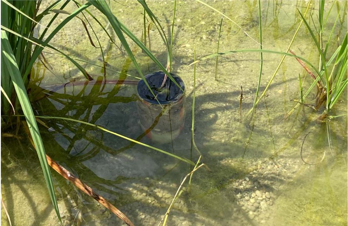
*Abbildung 13: Hydraulischer Kurzschluss über eingelegte Rohre auf der Saugseite des Pflanzensandfilters, 08.07.2021*
