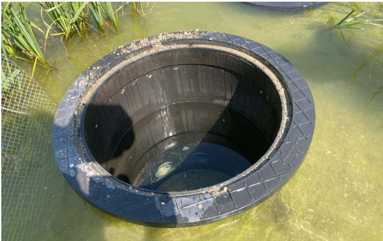
*Abbildung 12: Hydraulischer Widerstand im Filter saugseitig, sichtbar über den Niveauunterschied im Ansaugschacht und der Wasserfläche des Filters um den Schacht (ca 30cm Differenz), 21.07.2021*
