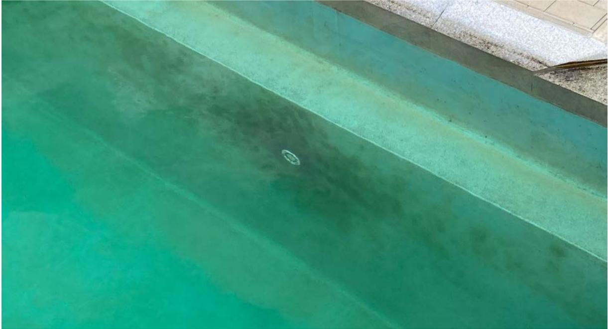
*Abbildung 4: Düsen mit seitlichen ausströmenden Schlitzen führen zu verstärkter Anströmung der Folien-Oberflächen und somit zu verstärkter lokaler Biofilmbildung, 16.09.2021*
