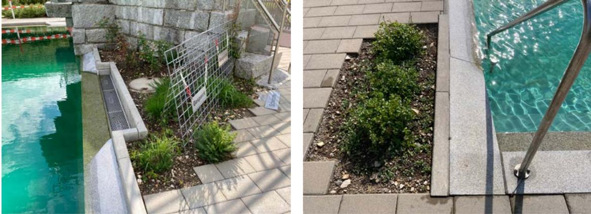
*Abbildung 1: Potenzielle Nährstoffeinträge durch nicht ausgefugte und an Wasserbecken grenzende Pflanzenbeete.*
