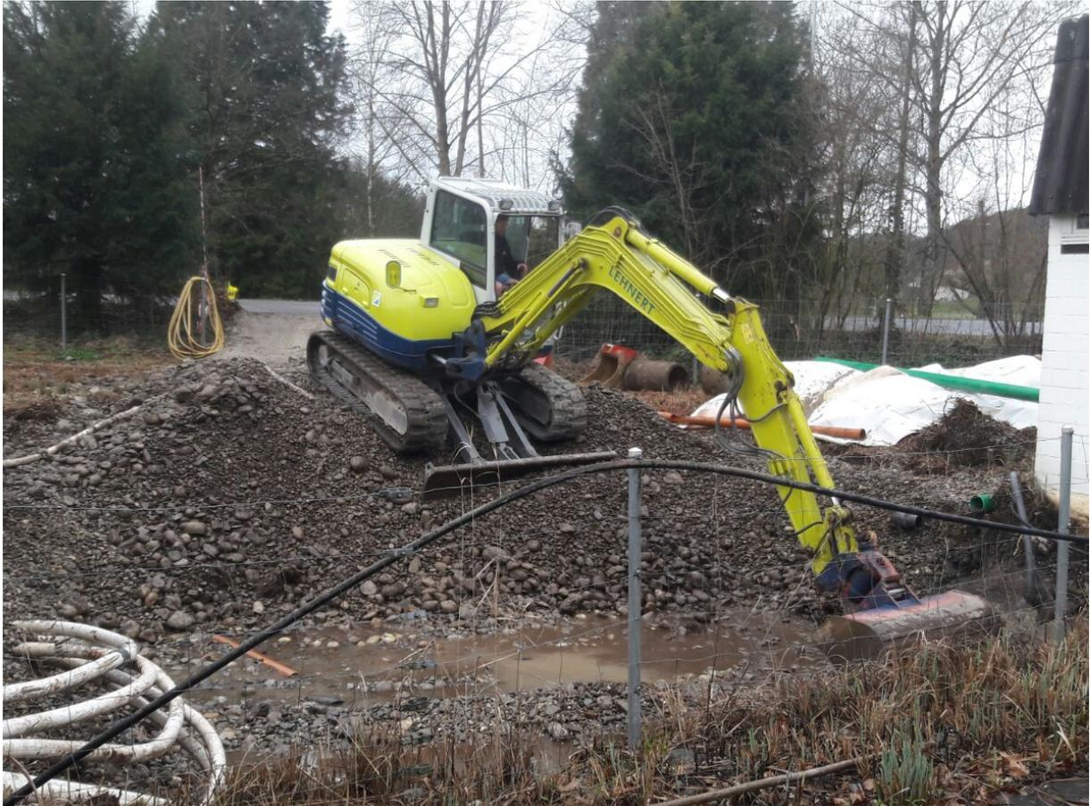
*Abbildung 37: Kiesfilter bepflanzt nach 15 Jahren Betrieb, Umbau wegen vermehrtem Aufkommen von Pseudomonas aeruginosa aufgrund ungleichmässiger Durchströmung/Kolmation.*
